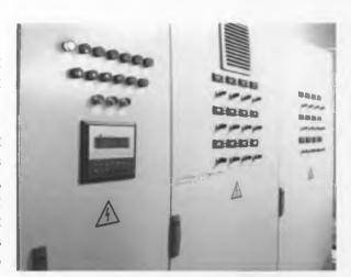
Щиты управления устанавливаются в машинном отделении в непосредственной близости от оборудования.
